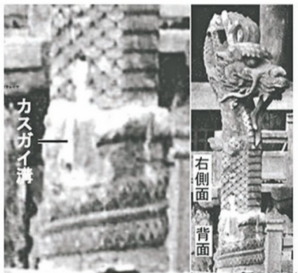
写真1：昭和修理竣工前の吡形大龍柱とトグロ巻き部背面の拡大。東京大学大学院工学系研究科建築学専攻所蔵
