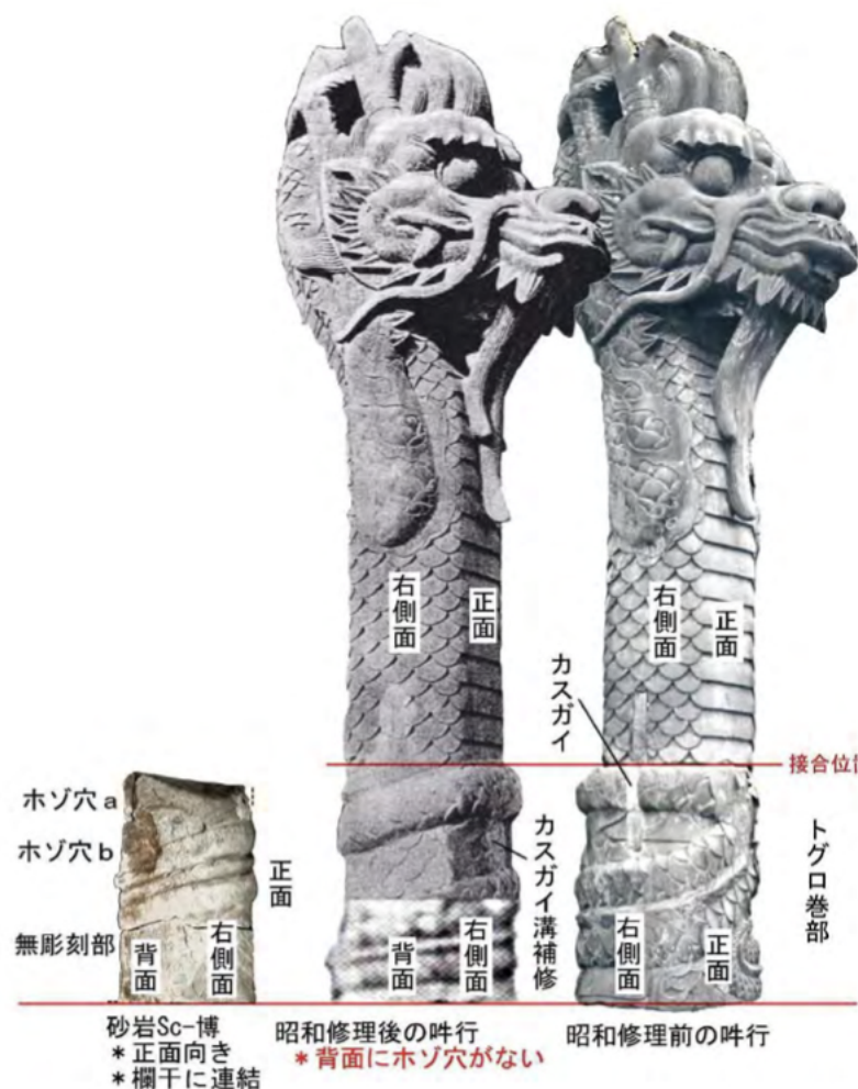
図3：吽形大龍柱の背面（欄干に連結するホゾ穴がない）
